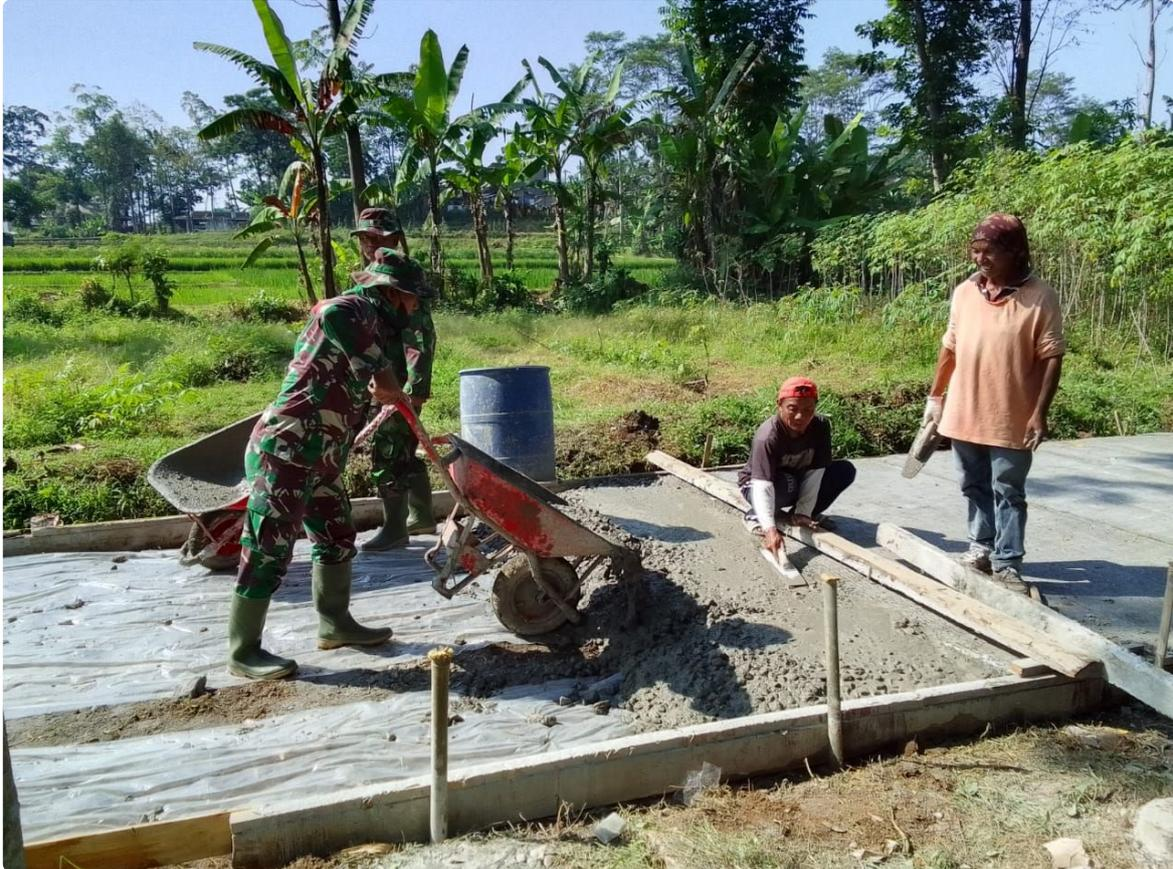
Bertepatan di lokasi Betonisasi jalan penghubung antara Jurang Gunting RT 02 RW 05 dan Krasak RT 02 RW 06 dengan lebar 3 meter, Panjang 325 meter, dalam proses pengerjaanya TNI dibantu warga setempat yang saling kerjasama saat pengerjaan Betonisasi jalan penghubung tersebut.
