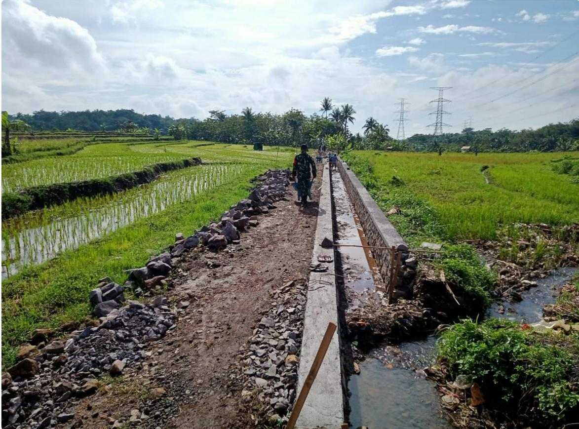
Pembuatan Talud Irigasi berfungsi selain memperlancar pengairan kesawah juga melindungi kondisi tanah dan mencegah timbulnya longsor akibat struktur tanah yang lembek serta mengoptimalkan dalam mengairi areal persawahan secara merata.
